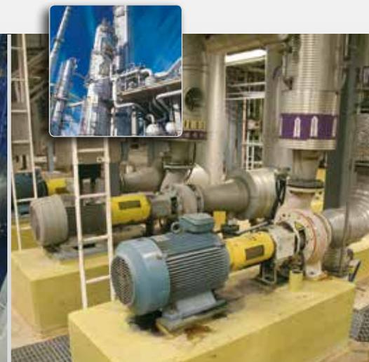
Easy-Laser® wird für die Ausrichtung von Pumpen und Motoren in allen Installationen und Industriezweigen verwendet. Korrekt installierte und ausgerichtete Maschinen sind eine Grundvoraussetzung für minimalen Energieverbrauch und lange Lebensdauer.
